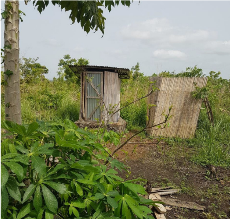
Bau 4 (Dusche rechts)
